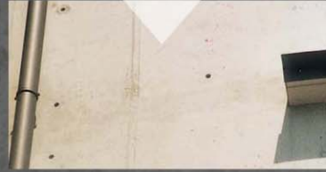
填補修飾後， 完全復原混凝土色澤
