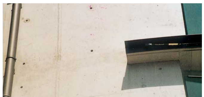
填補修飾後，大幅縮減或完全復原混凝土色澤
