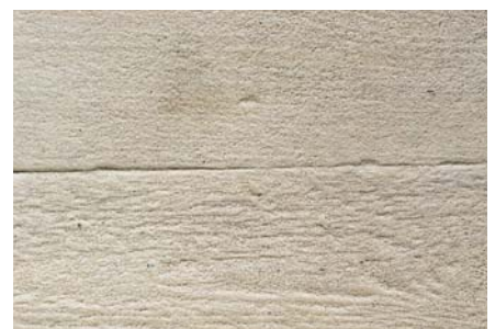
使用海綿或橡膠鏟刀作為補土工具，以保留原有模板紋理
