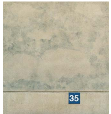
範例B：塗刷低稀釋比的半透明塗料
