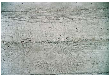
半透明塗層，確保混凝土氣孔不被堵塞
