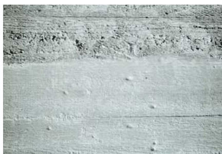
使用海綿或橡膠鏟刀作為補土工具，以保留原有模板紋理
