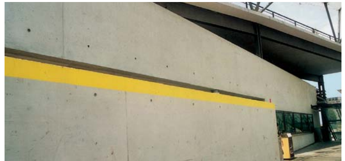
KEIM德國凱恩清水混凝土修飾塗料，可使混凝土表面均勻
