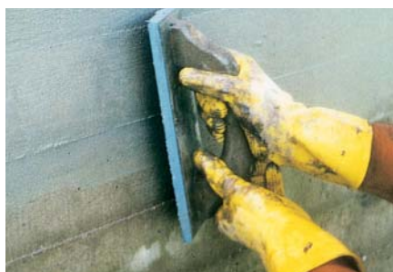
使用海綿或橡膠鏟刀作為補土工具，以保留原有模板紋理
