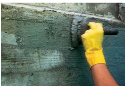
刷塗薄漿，保留原有的粗糙模板紋理
